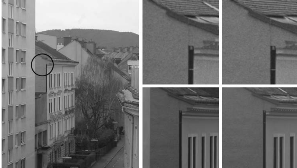
Abbildung 3: Korrelationsergebnisse an einer schwach strukturierten Gebäudefassade (links) zeigen deutlich die Überlegenheit der digitalen Aufnahme. Das Filmbildpaar (Rolleimetric 6006, c = 150 mm, AGFA APX) wurde mit 20 \mu\text{m} Pixelgröße abgetastet, das digitale Bildpaar mit c = 48 mm und einer Pixelgröße von 12 \mu\text{m} aufgenommen. Die Streuungen in den Horizontalparallaxen bei 100 Messpunkten betragen etwa 1/3 Pixel beim analogen Beispiel und 1/10 Pixel.
